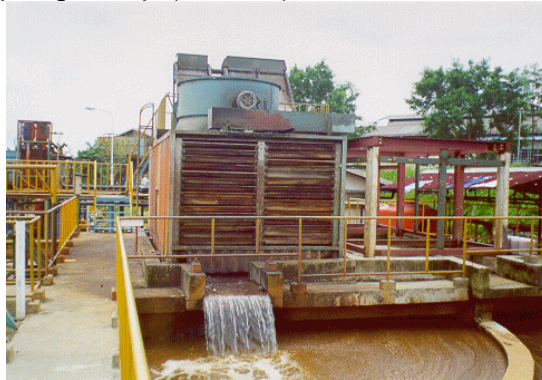
Gambar 10. Bak pengendap (clarifier) setelah diberi koagulan ferro sulfat.
