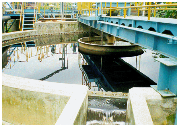
Gambar 14. Bak pengendap akhir
