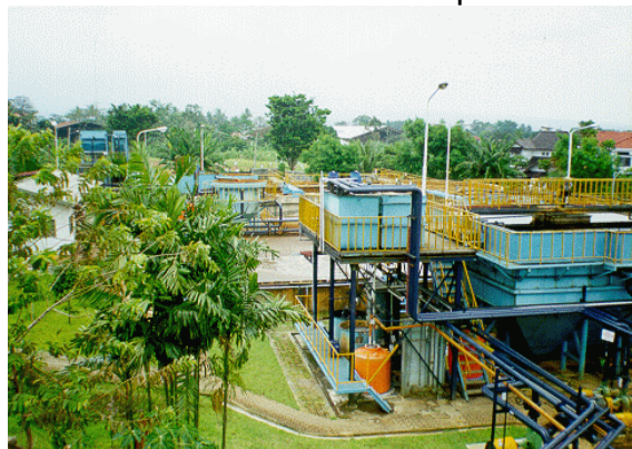
Gambar 6. Unit Pengolah Limbah Tekstil Kapasitas 200 m 3 /hari.
