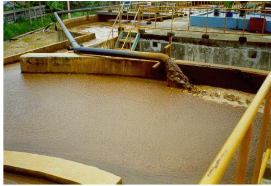
Gambar 13. Lumpur aktif dari bak pengendap akhir dikembalikan ke bak aerasi tahap pertama.
