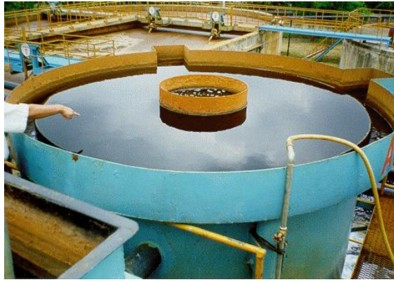
Gambar 10. Bak pengendap (clarifier) setelah diberi koagulan ferro sulfat.
