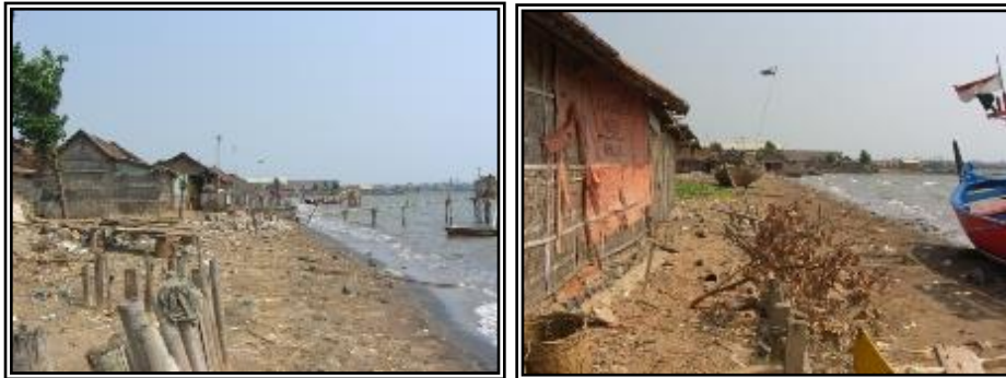
Kondisi Jarak Antara Bangunan Terhadap Tepi Pantai
