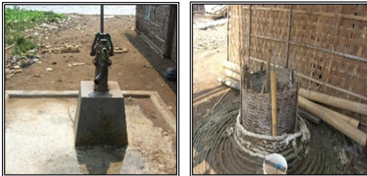
Pompa Air dan Sumur Gali Sebagai Salah Satu Sumber Air Bersih
