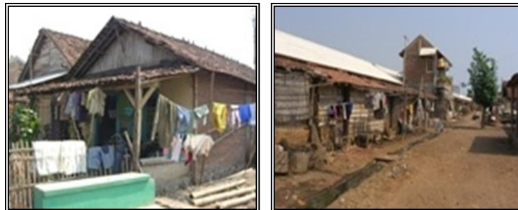
Indikasi Kerapatan Bangunan Yang Tinggi
