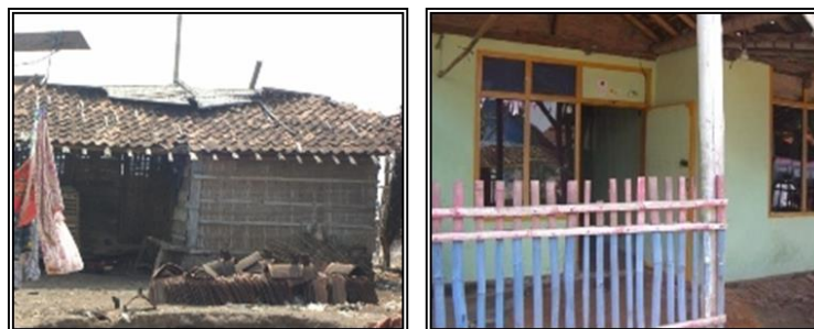
Bangunan Rumah Non Permanen dan Semi Permanen
